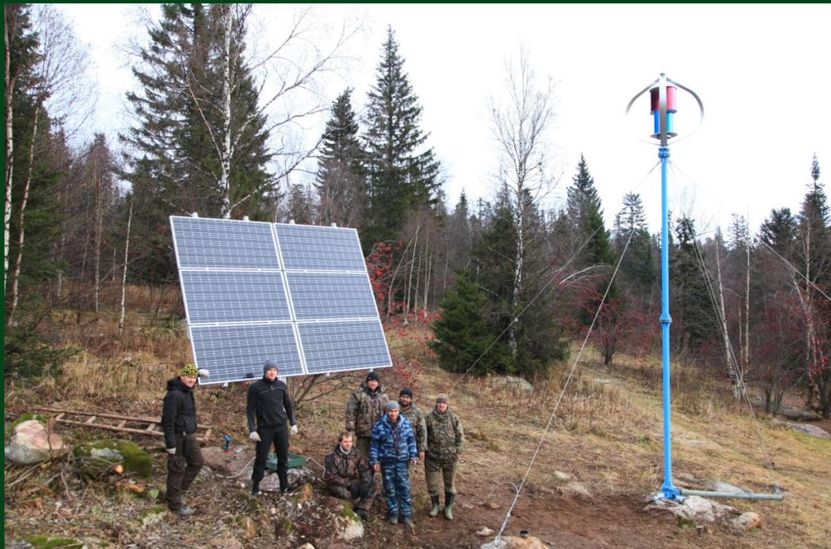
Система из солнце- и ветрогенератора автоматически управляется модулем мониторинга с компьютерным интерфейсом, способна вырабатывать до 8 кВт в сутки
